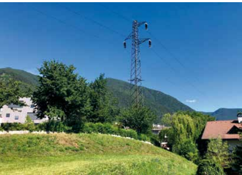
I cavi dell'alta tensione verranno spostati
